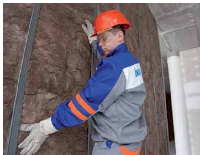
Referenčná stavba – príklad praktického použitia minerálnovláknitého materiálu TI 140 Decibel s ECOSE® Technology v ľahkých montovaných konštrukciách, ktoré oddelujú kancelárske priestory v tejto administratívnej budove.
