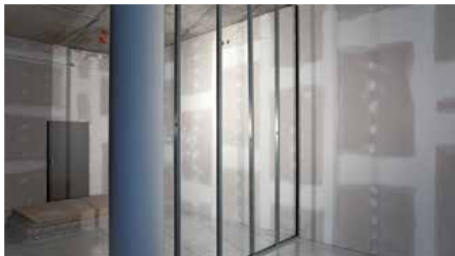
Kontrola správneho uchytenia roštovej konštrukcie
