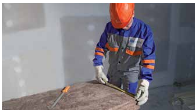
Meranie vopred stanovenej časti minerálnej izolácie, štandardná vzdialenosť je 625 mm
