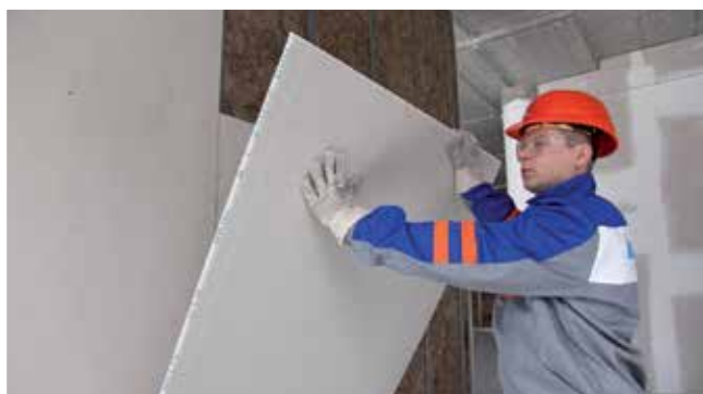
Inštalácia druhej vrstvy sadrokartónových dosiek na pripravený rošt, druhá vrstva musí prekryvať napojenie dosiek prvej vrstvy
