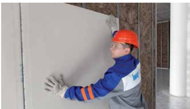
Inštalácia prvej vrstvy sadrokartónových dosiek na pripravený rošt
