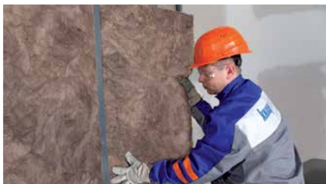
Aplikácia minerálnej izolácie do pripraveného roštu, vloženie ľahkým stlačením
