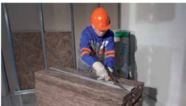
Rezanie vopred stanovenej časti minerálnej izolácie pre neštandardnú vzdialenosť
