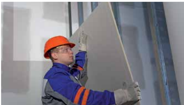
Inštalácia sadrokartónových dosiek na pripravený rošt
