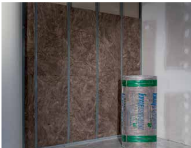
Referenčná stavba – príklad praktického použitia minerálnovláknitého materiálu TI 140 Decibel s ECOSE® Technology v ľahkých montovaných konštrukciách, ktoré oddelujú kancelárske priestory v tejto administratívnej budove.
